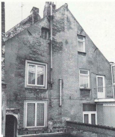
Afb. 3. De zwaar verbouwde, maar oorspronkelijk uit de bouwtijd daterende, achtergevel van het huis 'Cupenborch', gezien vanaf de platte daken van de recente achteraanbouwen (foto: BAD, 1988).
